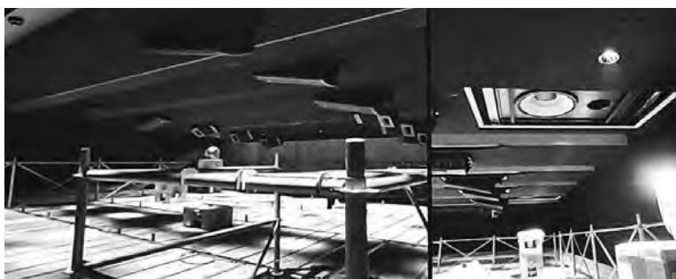
施工時の足場と天井面スピーカー
