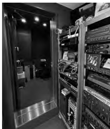
入口付近設置されたマシンラックと Vo ブース
